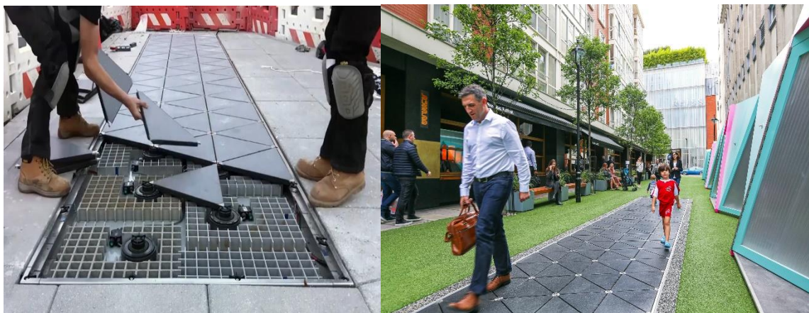
2-rasm. Piyodaning harakati natijasida elektr energiyasini olinishi.
