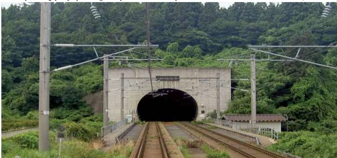
1-rasm. Temir yo'l tonneli
