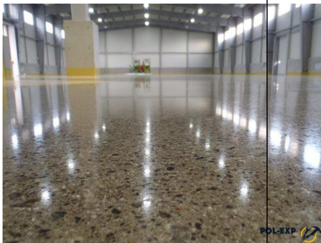
3-расм. Мрамар увоқларидан бетонли полларни қуриш
