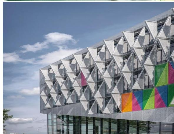
чередующихся железобетонных и стеклянных конструкций с алюминиевыми перфорированными внешними жалюзи, которые динамично меняются в течение суток. Трансформируемые пластины управляются специальными программами [7] и выполняют функции теплоизоляции, затемнения и санации (см. рисунок 4).
