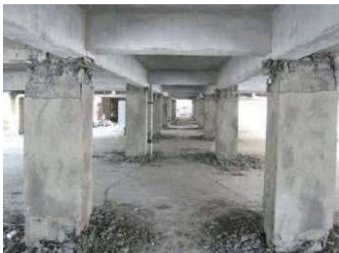
2-расм. Зилзила таъсирида устунларда пластик шарнир ҳосил бўлиши натижасида бузилиш
