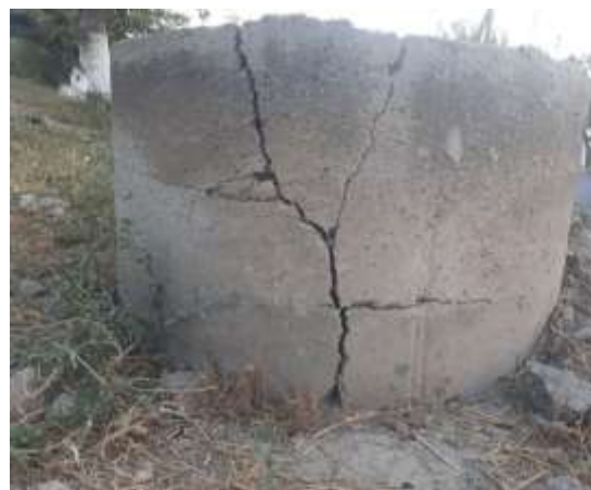
Расм. Бузилган ҳалқасимон темир-бетон конструкциялар
