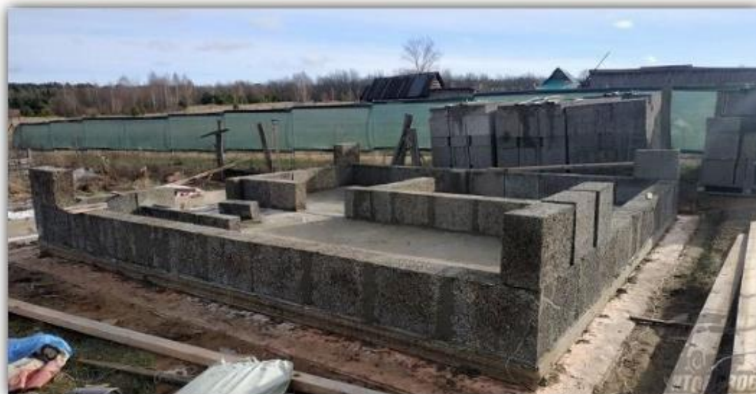
1-rasm. Arbolit betonning binolar qurilishida ishlatilishi
