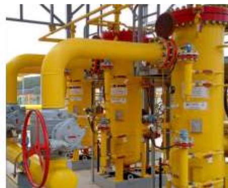
Кофлесцирующий фильтр топливного газа.
