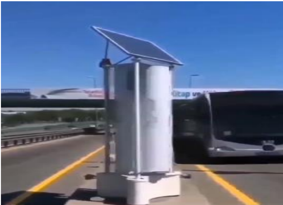
2-rasm. Ajratuvchi to'siqda shamol va yorug'lik energiyasidan elektr energiyasini olinishi.
