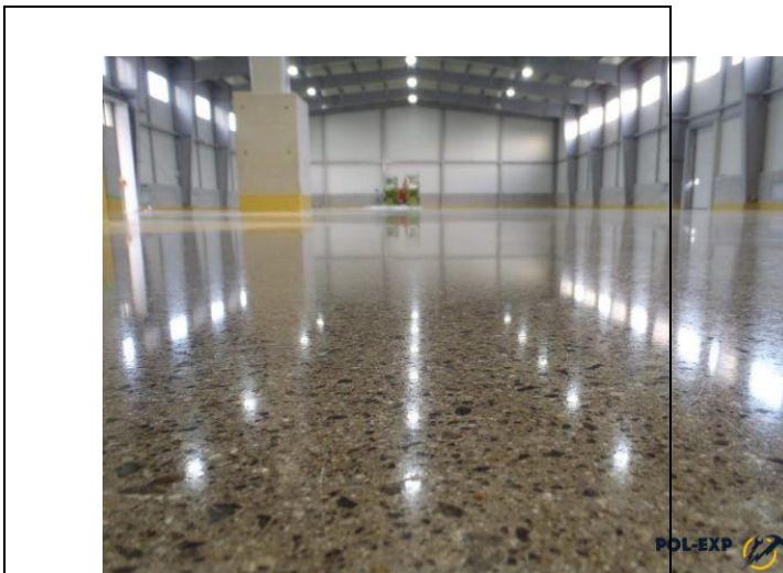
3-расм. Мрамар увоқларидан бетонли полларни қуриш
