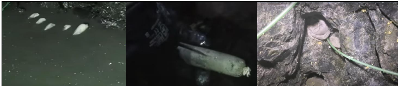
2-rasm. Zichlashuvchan mineralli tiqin bilan shpurni tiqin(zaboyka)lash tartibi
